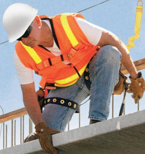
Des systèmes horizontaux avec ligne de vie qui offrent mobilité et protection contre les chutes pour les travailleurs en hauteur.
